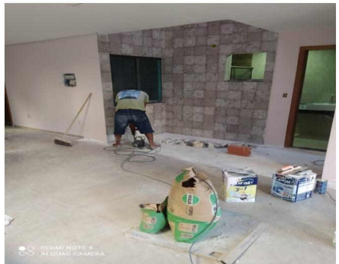
Figura 7. Operário quebrando concreto utilizando martetele
