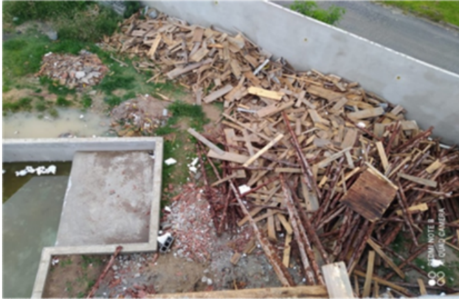
Figura 5. Detritos, restos de madeiras e entulho amontuado no canteiro de obras, com pregos não rebatidos
