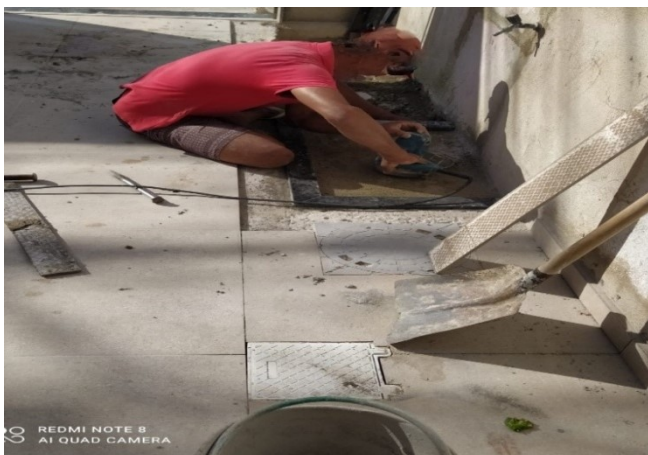
Figura 6. Operário cortando excesso de tubo com serra mármore
