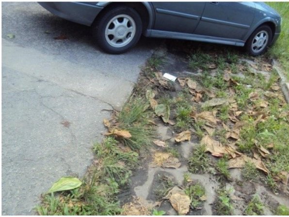
Figura 4. Presença de folhas na superfície do pavimento permeável
