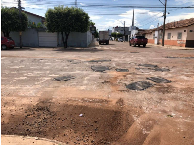
Figura 14. Remendos em perímetro urbano
