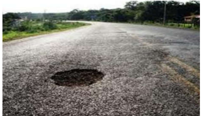
Figura 7. Buraco ou panela
