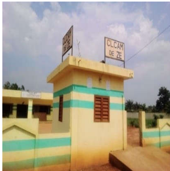
Photo 2_Le bâtiment d'une autre structure de crédit à Zè
