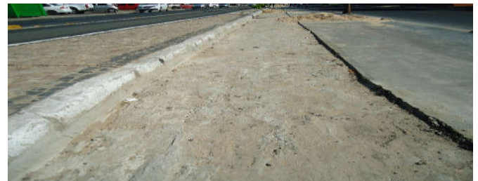
Figura 14. Capa de recobrimento do paralelepípedo com argamassa de cimento e areia
