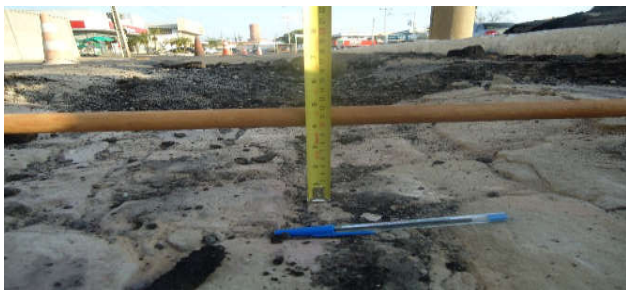
Figura 23 - Deformação da camada de paralelepípedo
