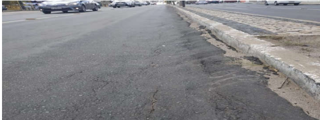
Figura 9. Trincas longitudinais a via
