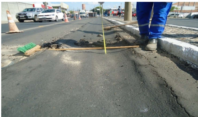
Figura 11. Trilhas de rodas no decorrer do corredor exclusivo
