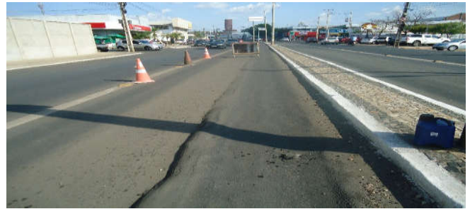
Figura 12 -Escorregamento da massa asfáltica
