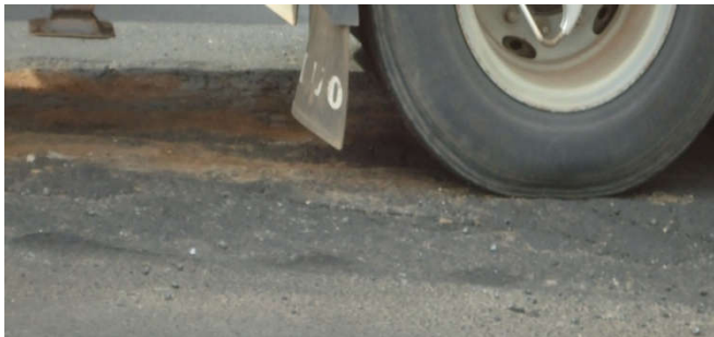
Figura 10. Afundamento do pavimento devido as cargas pneumáticas
